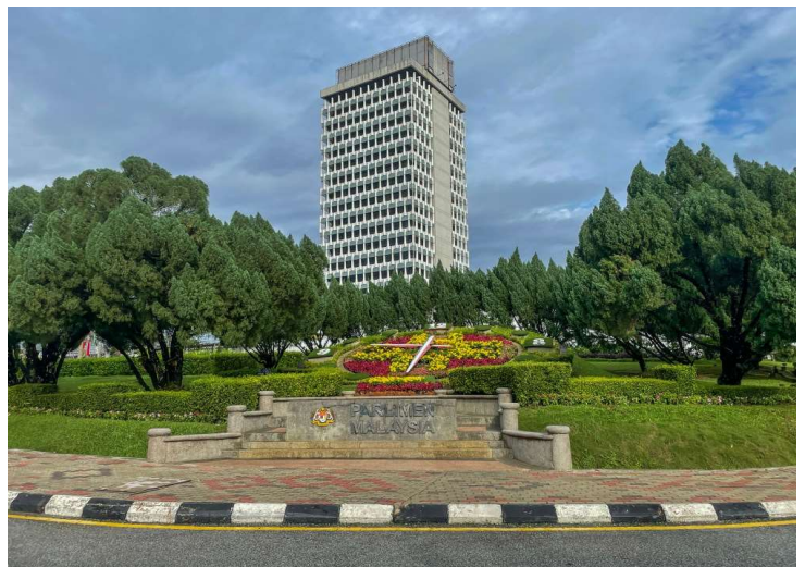
사진 5-1 말레이시아 의회 전경
